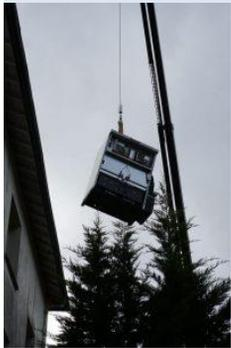
Il a fallu pour cela vaincre deux difficultés : le poids de l'appareil, mais également la difficulté d'accès. En effet, la configuration des lieux rend impossible l'approche de la chaufferie par un camion. L'opération a donc nécessité l'intervention d'un engin de levage pour, en deux temps, acheminer la chaudière, en passant au dessus des grands arbres, jusqu'à l'accès de la chaufferie en sous-sol.
