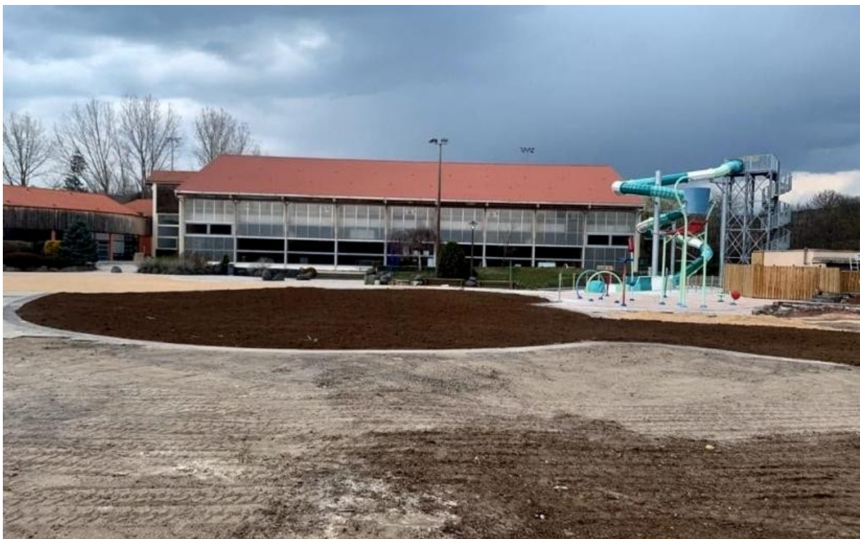
Les 720 m 2 de la piscine totalement ensevelie. Photo par DR
