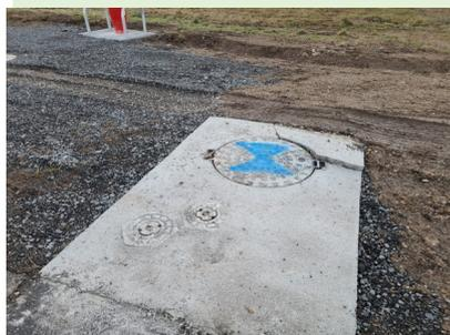
Malheureusement, quelques jours après l'achèvement des travaux un grumier est venu stationner juste sur le tampon en béton, fracturant celui-ci. Il a donc fallu reconstruire le toit de l'ouvrage et positionner deux grosses pierres de part et d'autre pour éviter que cela ne se renouvèle.
