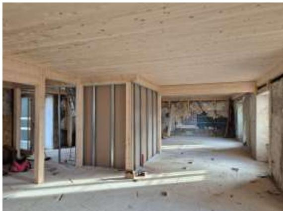
A l'issue de la trêve des confiseurs, les travaux ont repris avec la préparation de la pose de l'escalier et la mise en place des premières huisseries.
